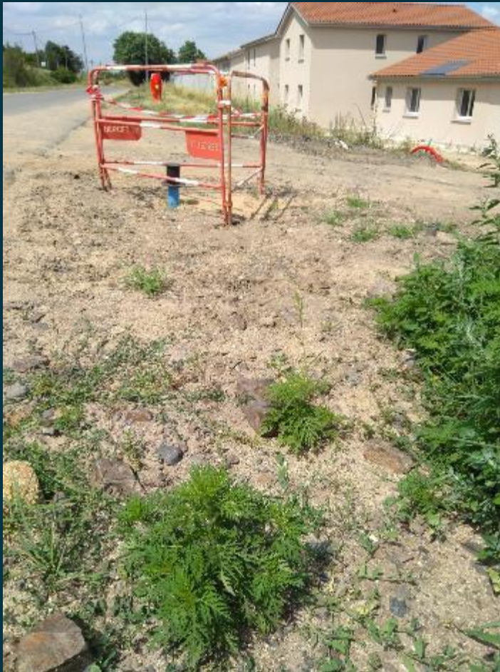
Zone de chantier
