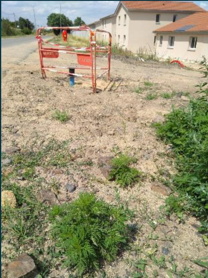
Zone de chantier
